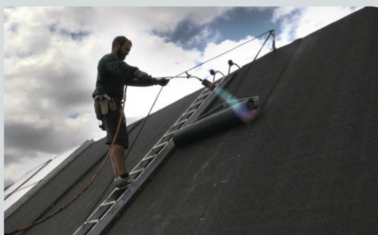
TAGPAPPEN FIRES NED MED EN HÅND UNDER BRÆNDING
